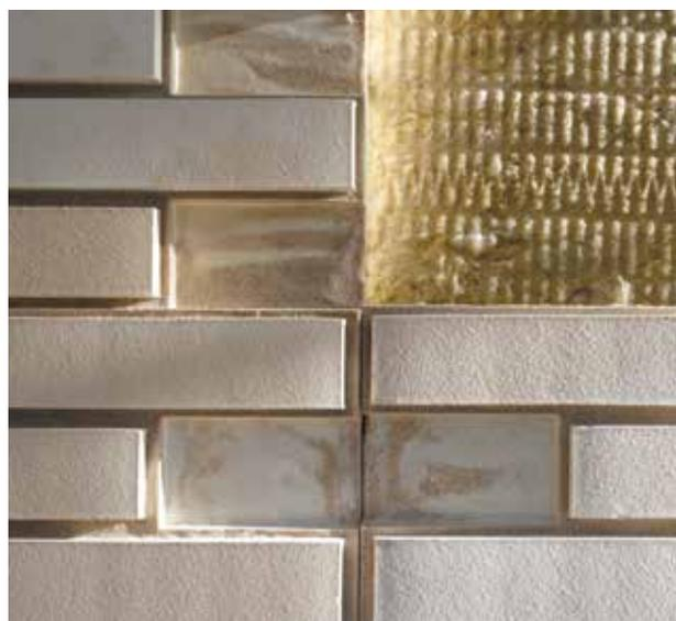
Les panneaux sont directement chevillés horizontalement ou verticalement sur la structure porteuse par des chevilles traversantes dont les têtes sont cachées par un bouchon de polystyrène puis jointoyées.
