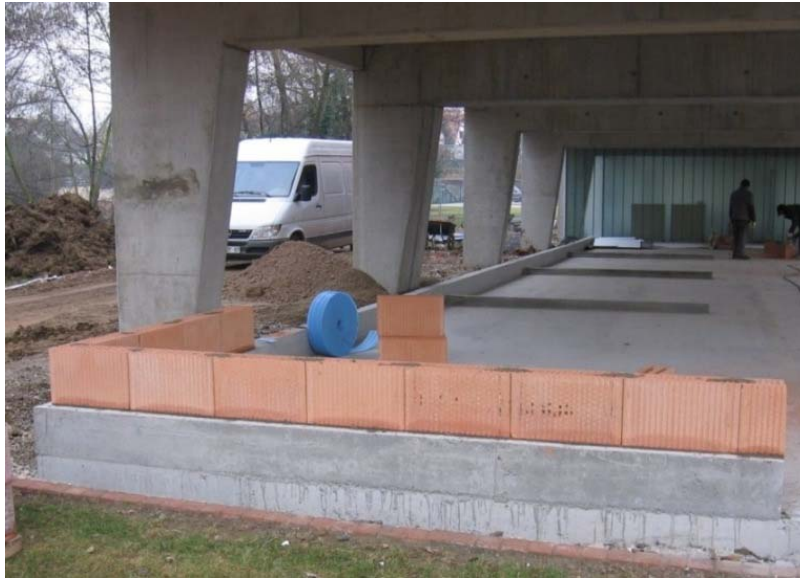
Figure 10– Pose du 1 er rang de briques (épaisseur 15 cm).
