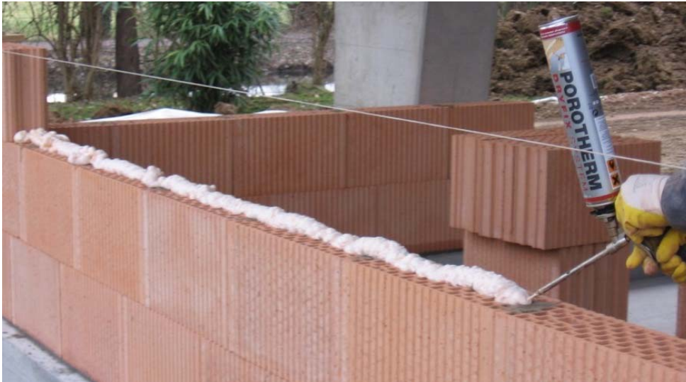
Figure 11– Application du DRYFIX® sur des briques d'épaisseur 15 cm.
