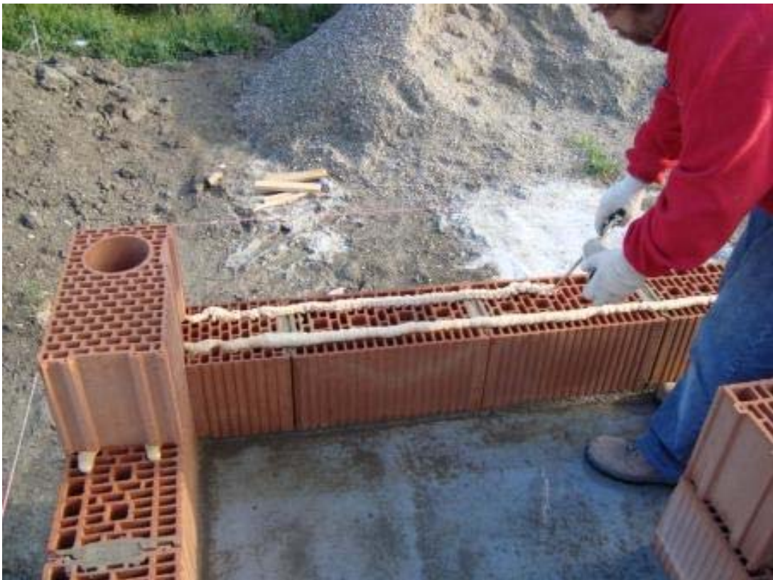
Figure 13 et 14 - Application du DRYFIX® sur des briques d'épaisseur 25 cm
