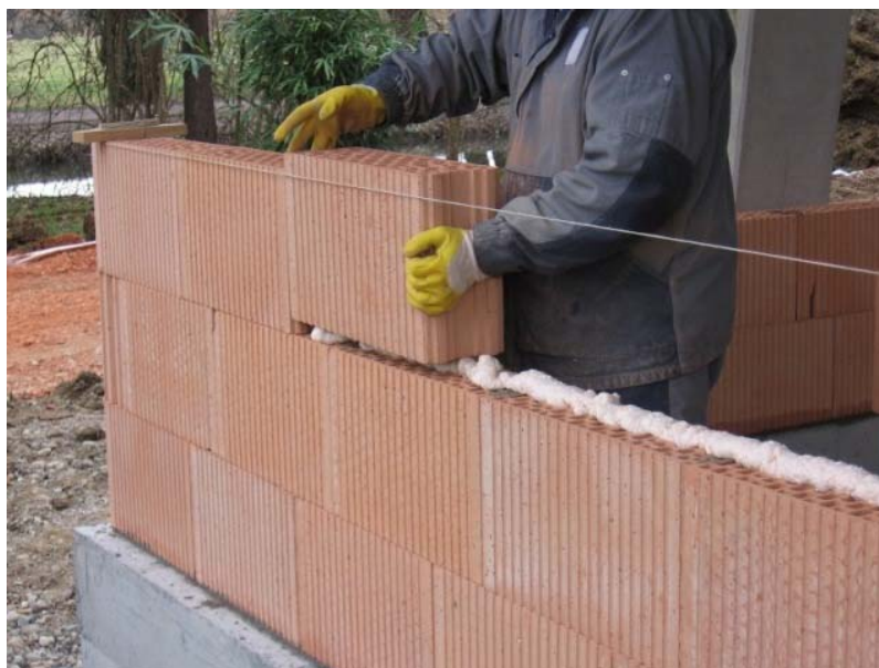
Figure 12– Assemblage de briques d'épaisseur 15 cm avec DRYFIX®.
