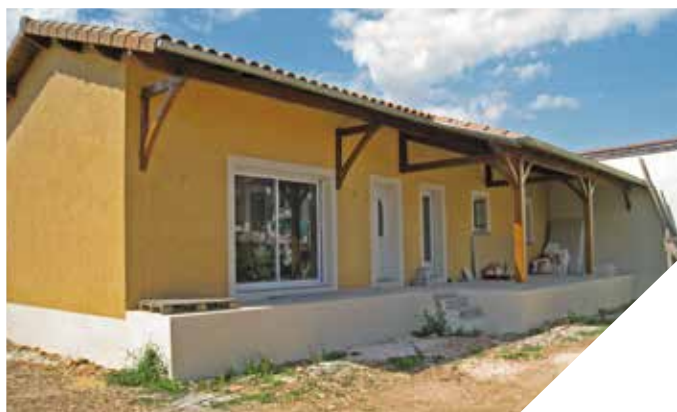
Villa mise en œuvre avec DRYFIX® réalisée par l'entreprise Zaccagnino.
