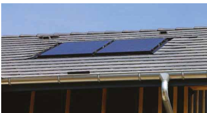
Installation surimposée
