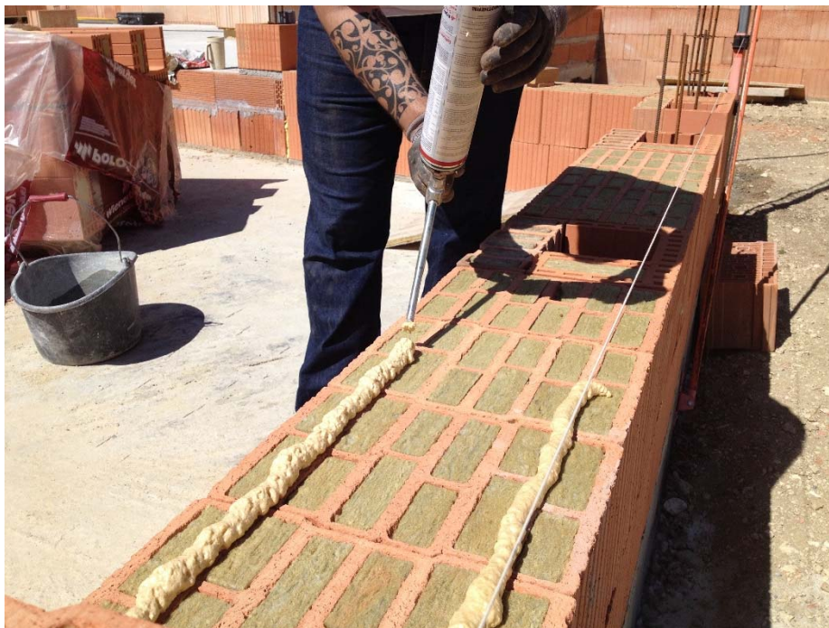
Figure 5– Application du Dryfix sur CLIMAmur 36
