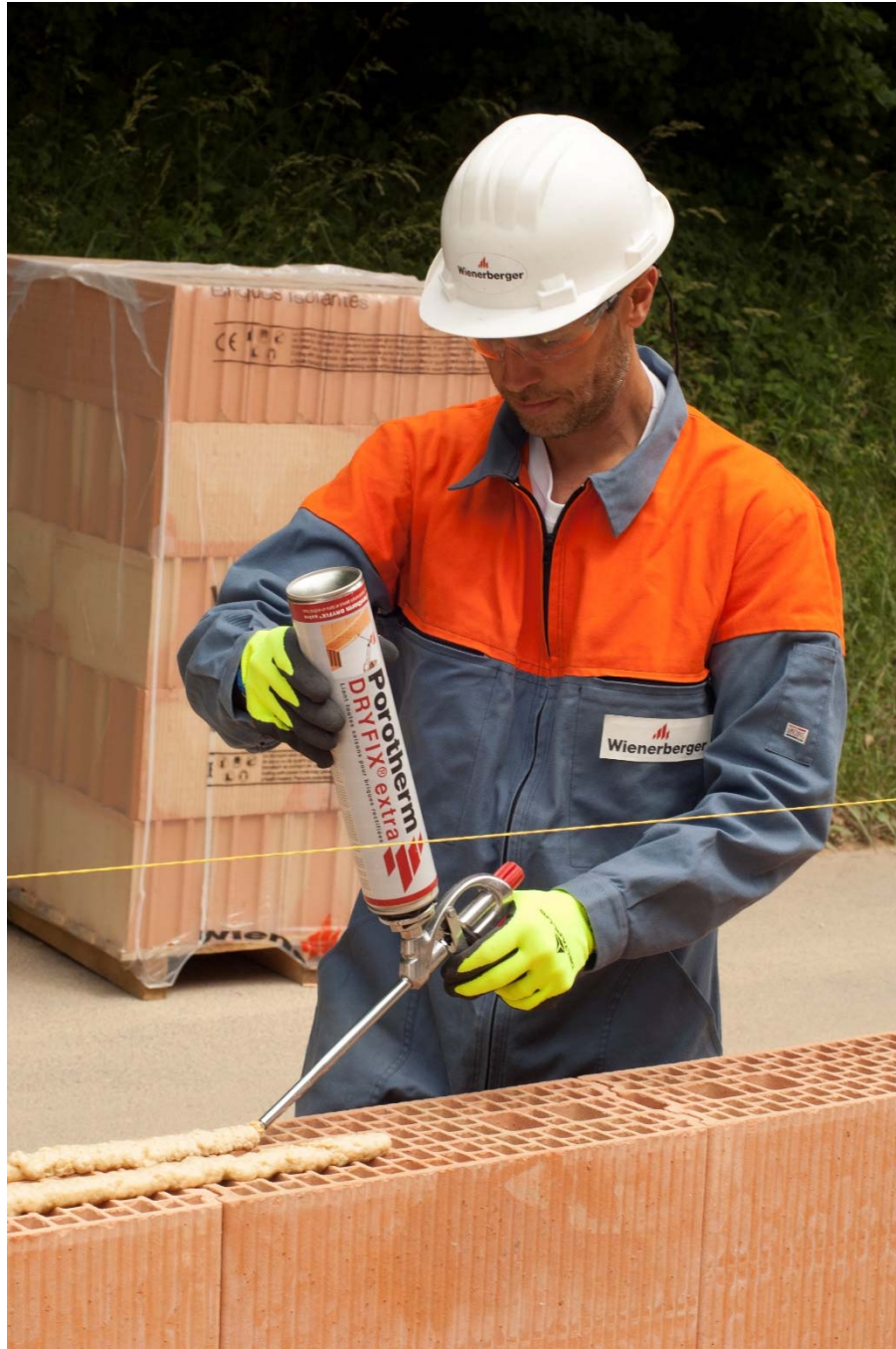
Figure 10 : assemblage au Dryfix
