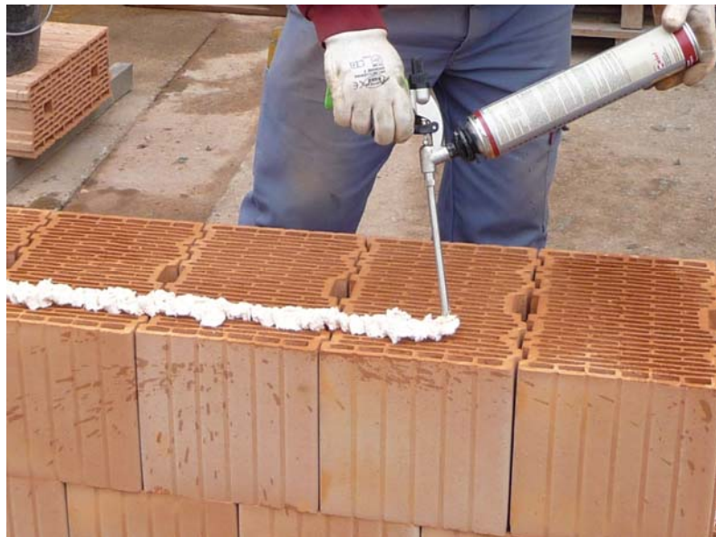
Figure 7– Application du DRYFIX® sur des briques d'épaisseur 37 cm.
