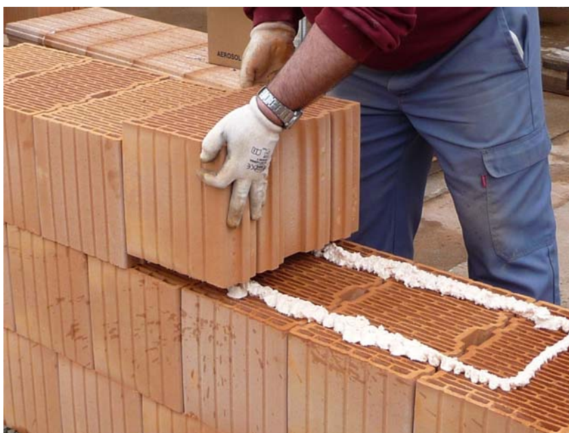
Figure 8– Pose des briques en partie courante.
