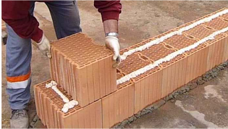
Figure 6– Pose du 1 er rang de briques (épaisseur 37,5 cm).
