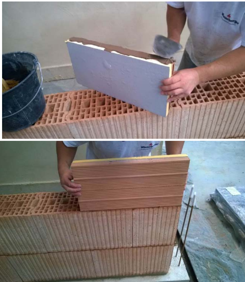
Figure 4 : mise en œuvre planelle ISO+
