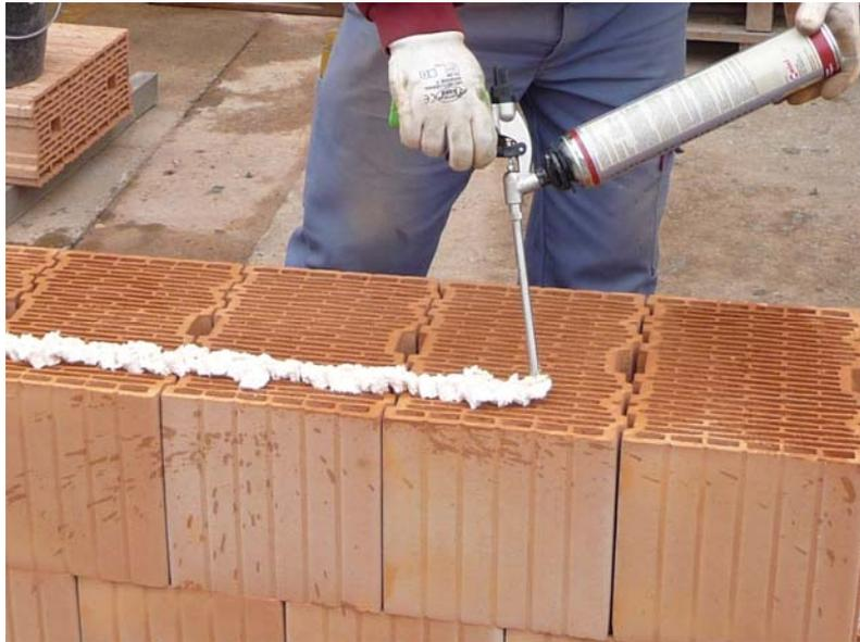
**Figure 8– Application du DRYFIX® sur des briques d'épaisseur 37 cm.**
