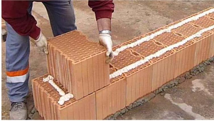
**Figure 7– Pose du 1<sup>er</sup> rang de briques (épaisseur 37,5 cm).**
