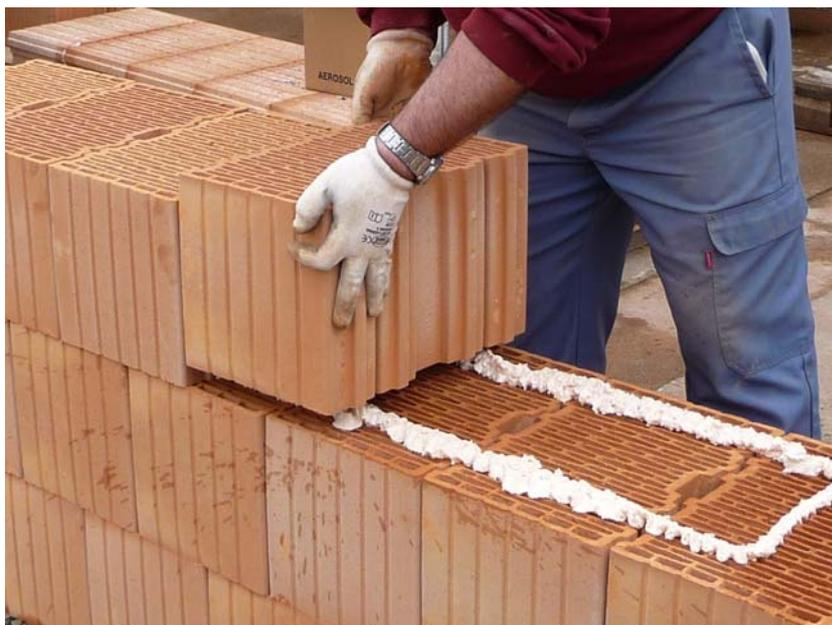
**Figure 9– Assemblage de briques d'épaisseur 37 cm avec DRYFIX®.**
